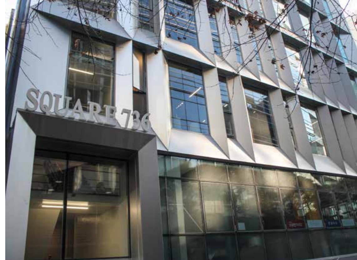
역삼동 365빌딩 SPEC: THK 4.0 AL.복합패널 코팅: 불소코팅 공법: 일반 Z-BAR 시스템 (코킹)
